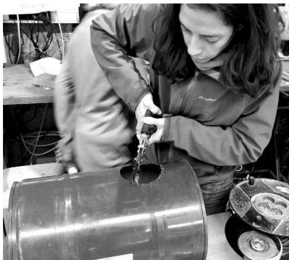
Photo 5: Découpe des languettes pour le passage du tube inox dans le bidon du foyer
