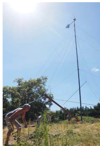
Figure 1: Éolienne levée, mât de 18m
