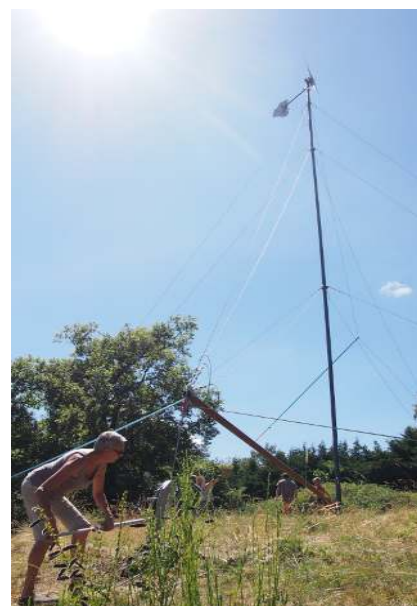
Figure 1: Éolienne levée, mât de 18m
