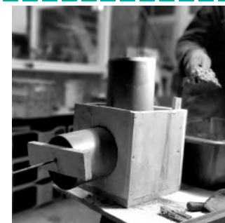
Photo 4: Assemblage du coffrage et moulage du foyer
