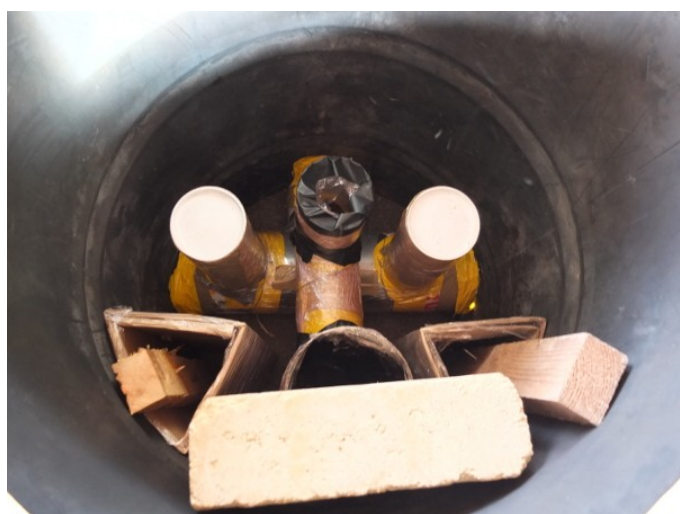
L'ensemble en place prêt à couler, avec des maintiens (tasseaux et briques) en plus des fils de fer
