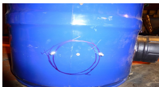
Tracé de l'ouverture maximum autorisée par la réservation : au centre la vis qui maintient le coffrage, de part et d'autre les 2 boulons déjà en place avant le coulage pour fixer la trappe.
