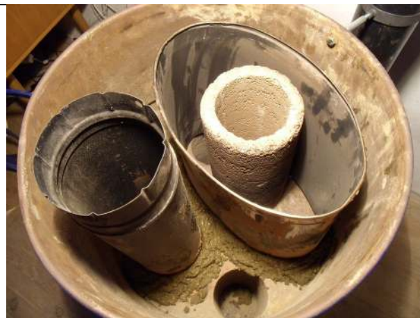
Scellement au mortier
