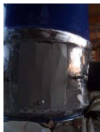
Tracé de l'ouverture maximum autorisée par la réservation : au centre la vis qui maintient le coffrage, de part et d'autre les 2 boulons déjà en place avant le coulage pour fixer la trappe.
