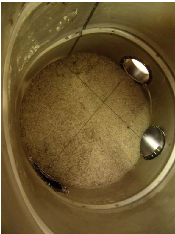
Axe du collecteur avec trappe de ramonage en attente.
