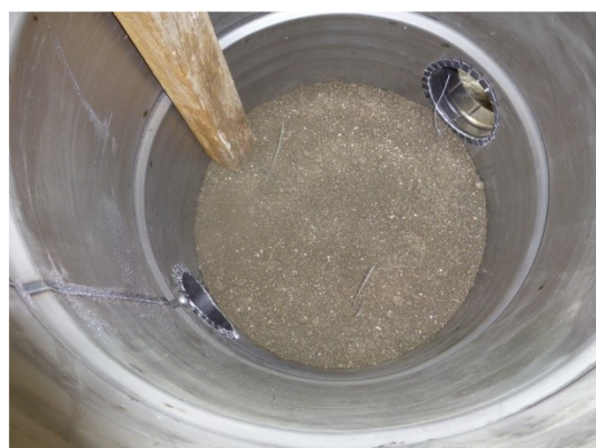
Première couche isolante à gauche,
