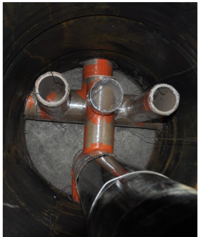
Le tout bien en place, ne manquent que les puits de sable avant de pouvoir couler ...
