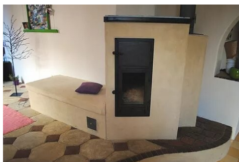
Figure 1: Poêle BatchBlock V1 enduit réalisé par un autoconstructeur- uzume.fr
