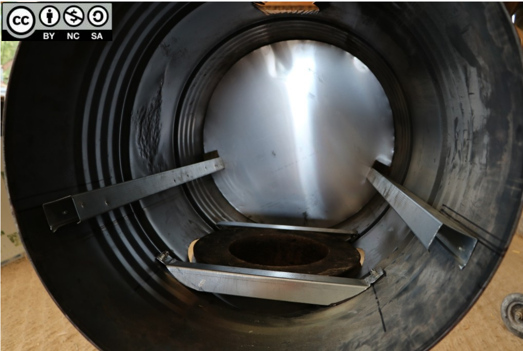
Découpe trou évacuation et brûleur, fixation poignées, mise en place fond isolant, fixation des cornières du brûleur et des rails de support
