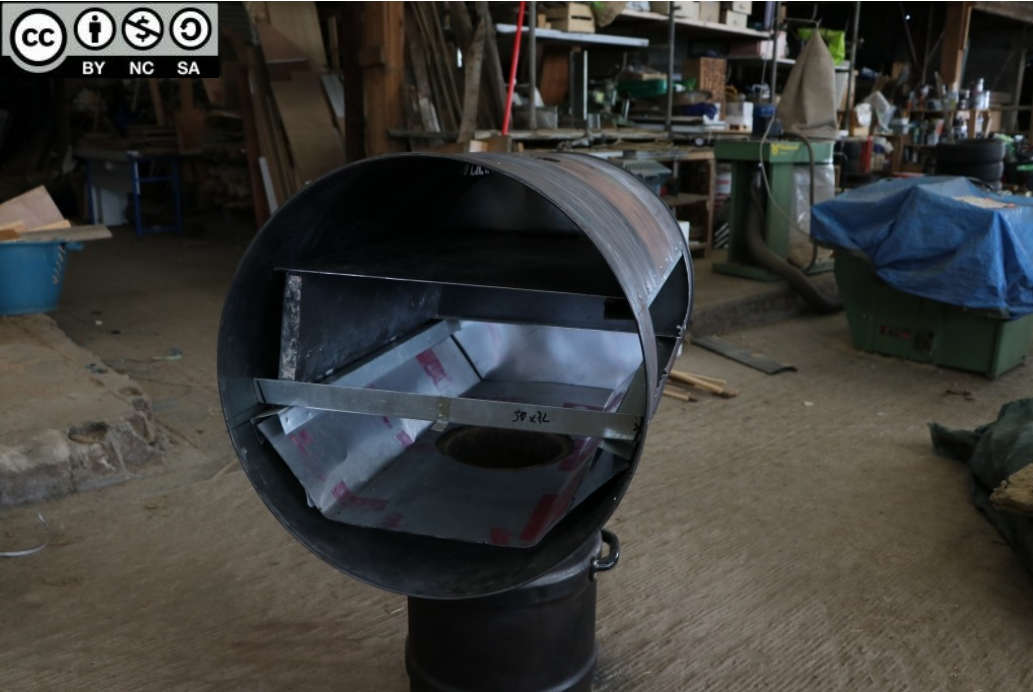
Découpe tôle toit et mise en place
