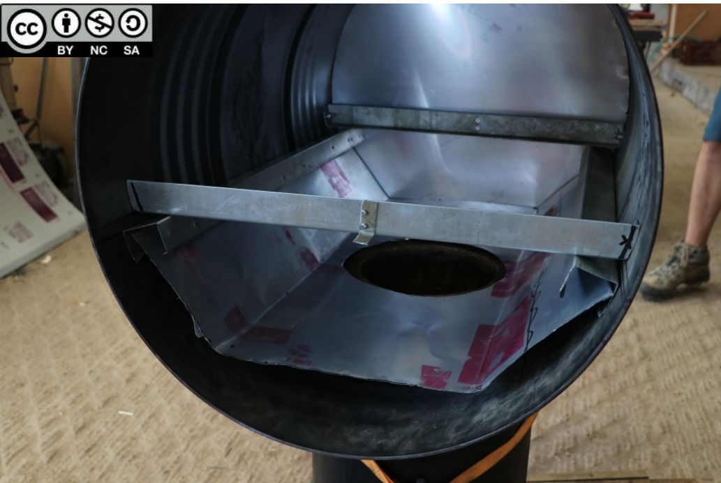
Fixation cornière support dalle, mise en place plaque protection isolant et petite cale passage fumées
