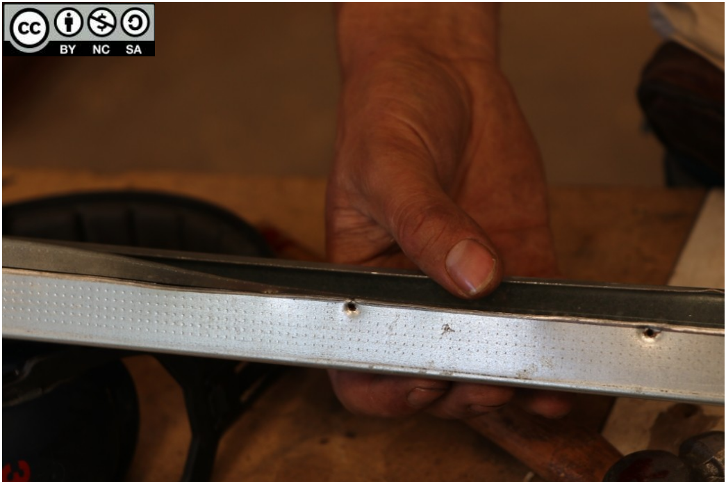
Déformation du rail placo linteau avec meuleuse et marteau
