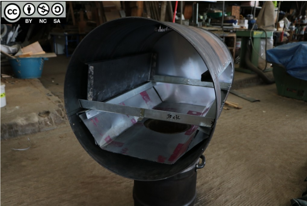
Découpe et pliage tôle fond et mise en place
