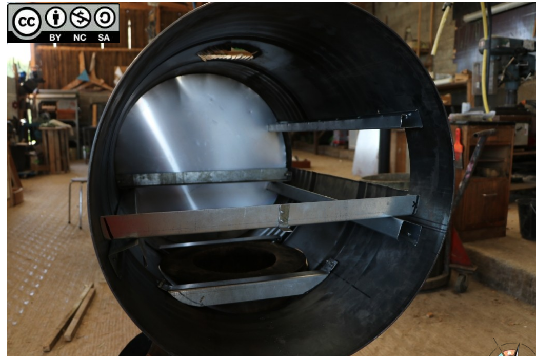
Découpe ouverture four et mise en place rail placo linteau
