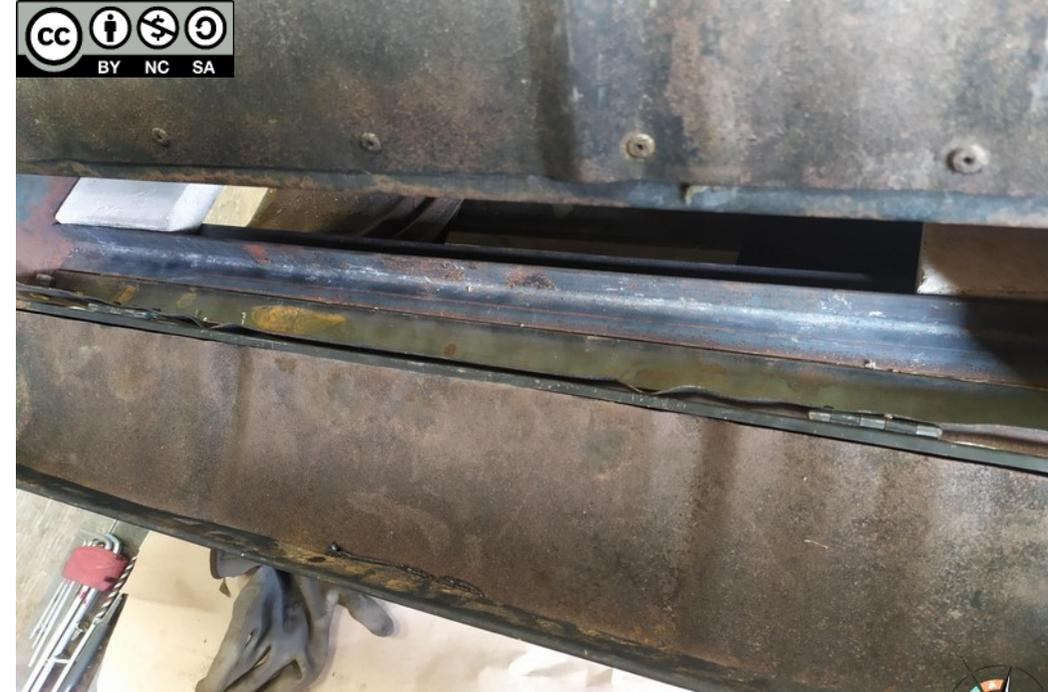
Pose de la laine de roche et du fer plat, il doit être au même niveau que le té sinon ajuster la laine de roche
