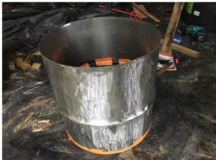
A gauche, flou, et à droite : la partie basse du bidon du haut est bâchée pour être sûr qu'en coulant le béton de la partie du bas, il ne prenne pas la partie du haut en même temps. On s'était dit qu'on voulait absolument garder la partie haute pour le coulage de la basse pour faire dépasser le béton, afin que ça fasse un gros légo à emboîter.
