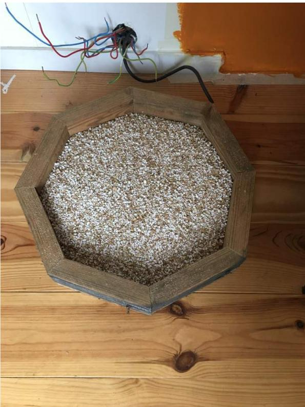
Fabrication du socle avec de la vermiculite qui reste.
