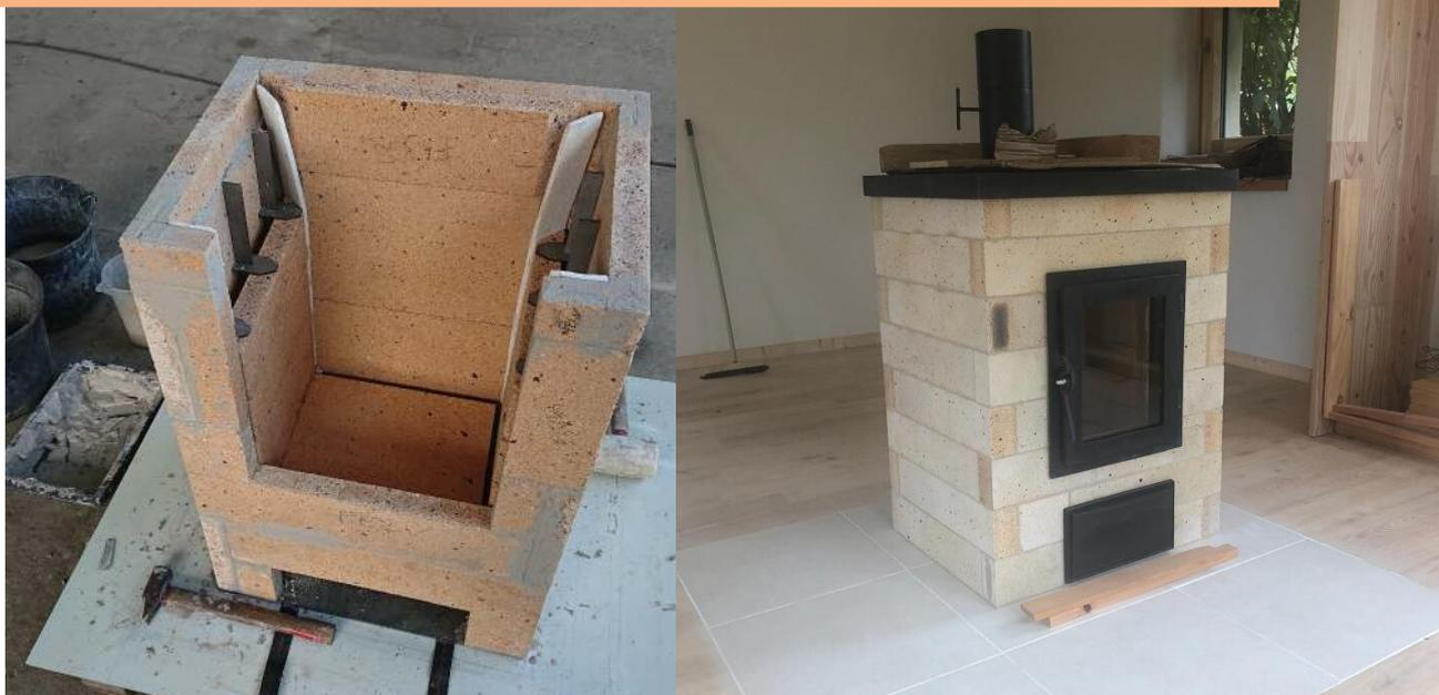
Le *Minimasse* est un petit poêle de masse, à combustion optimisée, transportable de 500kg prévu pour chauffer et cuisiner en habitat de petite surface (entre 30 et 80m<sup>2</sup>). Idéal pour éviter les surchauffes des petits espaces, et garder dans sa petite maison une température la plus constante possible! Nos stages de fabrication se basent sur le modèle développé par Agir Lowtech dont nous sommes membres contributeurs. .
