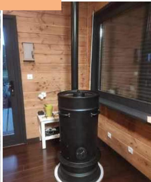
Le *Poelito* est un poêle de semi-masse, à combustion optimisée, semi démontable pour chauffer et cuisiner en habitat léger. Idéal pour éviter les surchauffes des petits espaces, et les réveils glacials des habitats légers ! Nos stages de fabrication se basent sur le modèle développé par Vital Bies. Ils sont aussi l'occasion d'aborder les notions de confort thermique et combustion entre étapes de fabrication.
