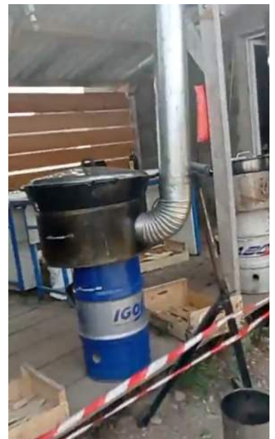
Exemple de maintien de la fumisterie avec une servante d'atelier
